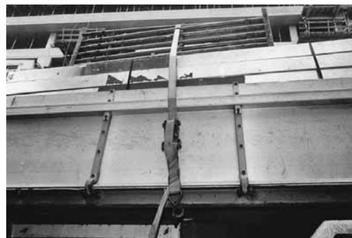
Bild 4: Sichere Befestigung der Ladung.
